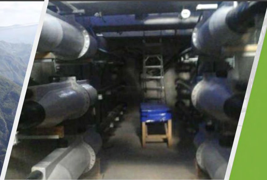
KM-C DE LÍNEAS SUBTERRANEAS
